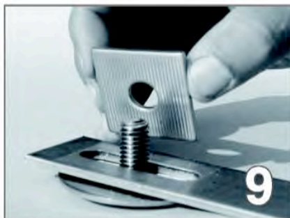
Haltewinkel und Rasterbeilage einrichten und festschrauben. Haltewinkel gegebenenfalls auf notwendige Höhe kürzen
