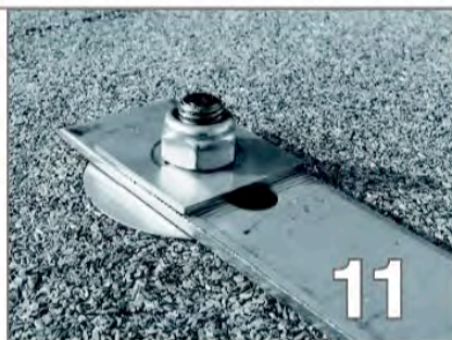
Haltewinkel und Rasterbeilage einrichten und festschrauben. Haltewinkel gegebenenfalls auf notwendige Höhe kürzen
