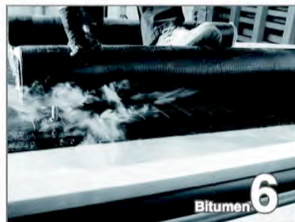
Letzte Abdichtungslage der Bitumenbahnen bis zur Vorderkante des Traufenbleches kleben – dadurch können die Stösse ohne Dila überflämmt werden!
