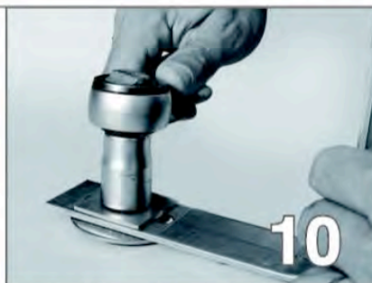
Haltewinkel und Rasterbeilage einrichten und festschrauben. Haltewinkel gegebenenfalls auf notwendige Höhe kürzen
