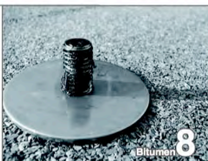
Schraubenstifte der Grundplatte gegenentfalls reinigen und Anpressscheibe mit Konusbohrung nach unten aufsetzen.
