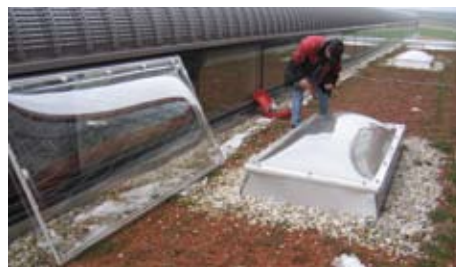
Firma Sadler beim Montieren der neuen Sadler-Likunet-Kuppel.
