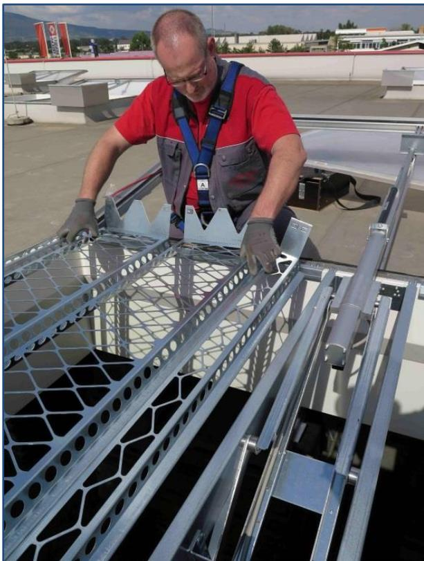
Zusammengefügttem Gitterkorb in die Eihangleisten einhängen und in der Öffnung ausrichten.
