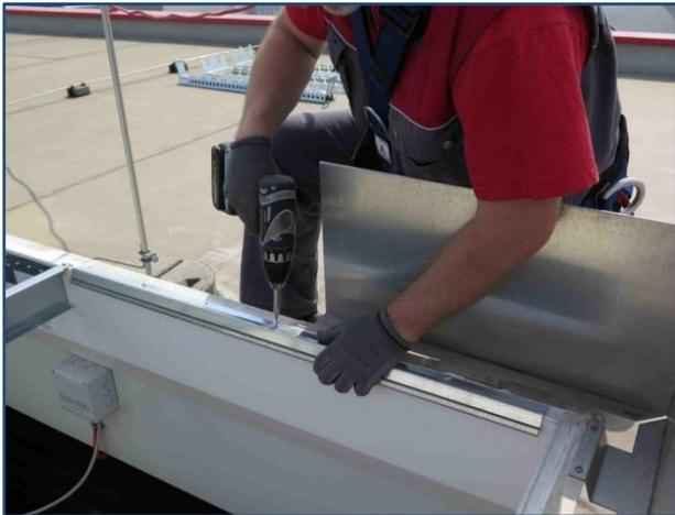
Eihangleisten werden in der Länge an den Aufsatzkranz angepasst und an sämtlich vorgebohrten Löchern mit den mitgelieferten Schrauben am Aufsatzkranz befestigt
