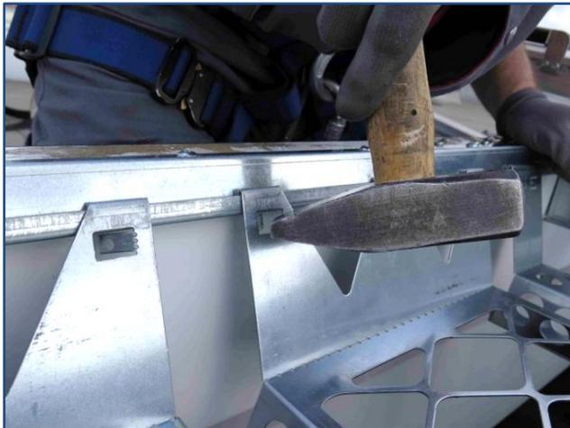
Die vorgestanzten Sicherungslaschen werden mittels kleinem Hammer oder Schraubendreher eingebogen, um die Module in der Einhängeleiste gegen Aushängen zu sichern.
