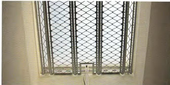
Flexibel und sicher: Montierte Likunet-„saniflex“-Module mit Lüftungsmotor-Ausschnitt.
