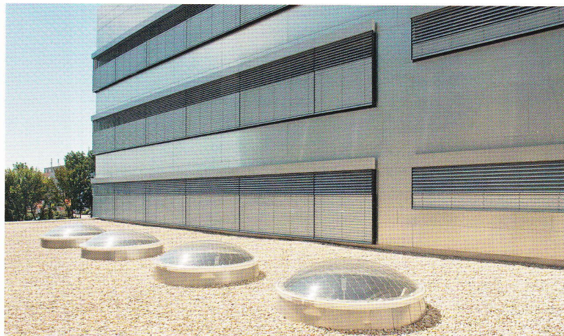
↑ Eine sichere und elegante Lösung bei runden Lichtkuppeln für die FH in St. Pölten.
