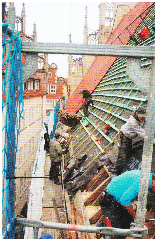
↑ Montage eines Laufbretthakens.
